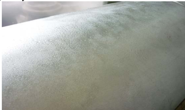
Рис. 6. Конденсация влаги на наружную поверхность воздухоосушителя
